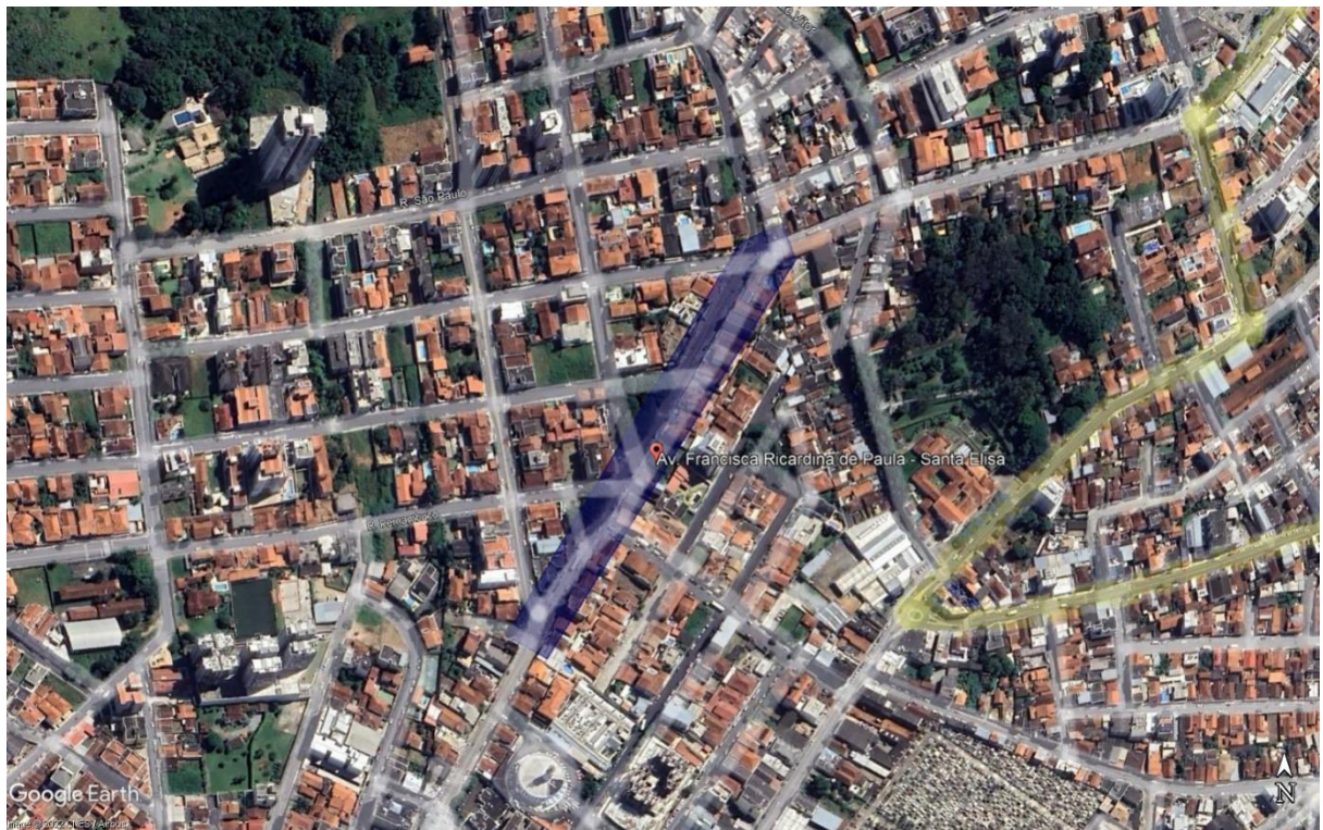
Figura 3 – Área de Abrangência do Projeto – Drenagem da Rua Francisca Ricardina de Paula
